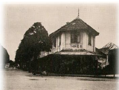
ตึกแถวซึ่งครั้งหนึ่งเป็นสถานที่เปิดสอนโรงเรียนราษฎร์แห่งแรกในนครปฐม เมื่อ พ.ศ. ๒๔๔๙
